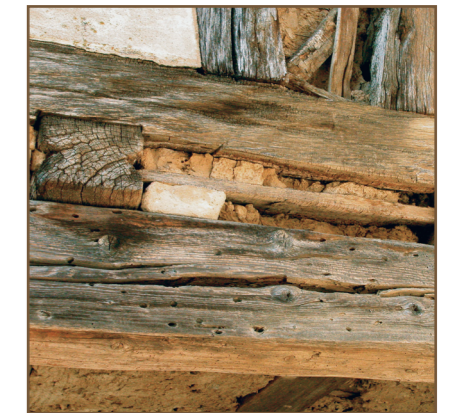
Système constructif d'un plancher : sablière, solive, poutre
